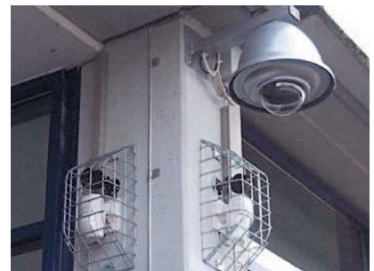
Ob aktuell mit oder ohne Kamera bestückt, ist nicht erkennbar: Videoüberwachungslösung „ContraVandalis“ der MAB-Meldeanlagenbau GmbH, Bissendorf. Die Lösung setzt auf Abschreckung nach dem aus der Verkehrsüberwachung bekannten Starenkasten-Prinzip. Betroffene wissen nicht, ob sie gerade überwacht werden. Mit dem System lassen sich laut MAB die datenschutzrechtlichen Vorgaben einhalten. Bild: MAB
